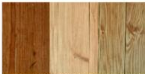
Il pavimento vecchio, lamato, spazzolato e oliato ha ottenuto un significativo valore aggiunto. (Foto 3)
